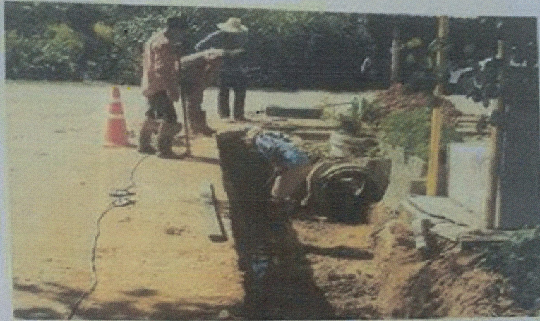
ภาพถ่ายการดำเนินการแก้ไขปัญหาน้ำท่วมบริเวณถนนสุขาภิบาล ๖ แยกถนนสุขาภิบาล ๗ ตามหนังสือร้องเรียนปัญหาน้ำท่วมถนน ลงวันที่ ๒๗ ตุลาคม ๒๕๕๘
